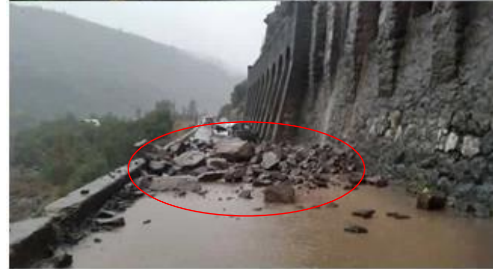
Túnel El Tinoco
